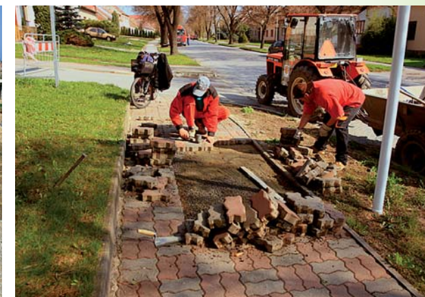
„DOMEČEK“ – BUDOVÁNÍ BEZBARIÉROVÉHO VSTUPU (UL. BEZRUČOVA)
